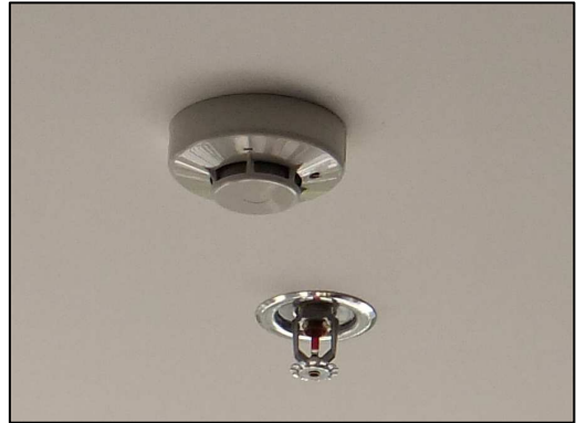
ภาพที่ 2-8 Smoke Detector & Sprinkler
